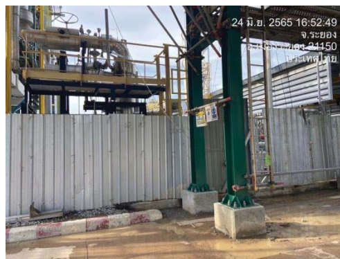
รูปที่ 3.2-56 การปิดกั้นพื้นที่ปฏิบัติงานรอบแนวท่อส่งก๊าซธรรมชาติในระหว่างดำเนินการซ่อมบำรุง
