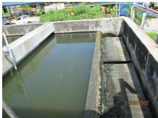
รูปที่ 3.2-5 บ่อปรับสภาพน้ำเสีย (Neutralization Pond)
