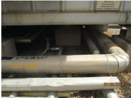
รูปที่ 3.2-1 Steam Injection System
