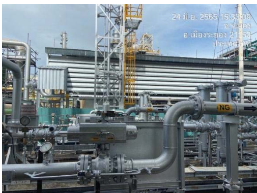
รูปที่ 3.2-47 ตัวอย่างวาล์วควบคุม 2 ชั้น ในระบบก๊าซ NG
