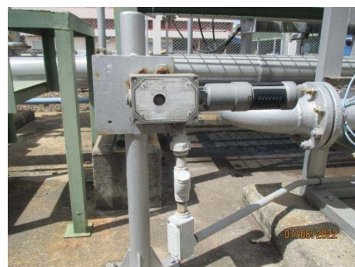
รูปที่ 3.2-48 ตัวอย่างอุปกรณ์ตรวจจับการรั่วไหล ของ NG ที่เชื่อมต่อกับระบบควบคุมการทำงาน ของกังหันก๊าซและหม้อไอน้ำ
